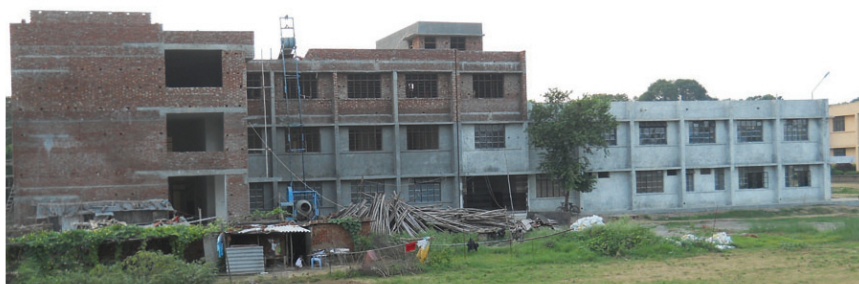
Het nieuwe schoolgebouw is nog niet helemaal af, maar wel ver genoeg om het zoals gepland in juli in gebruik te kunnen nemen.
